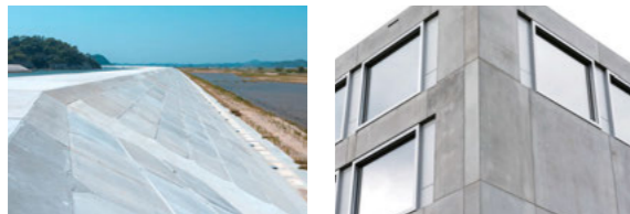
防波堤(湾岸施設)
